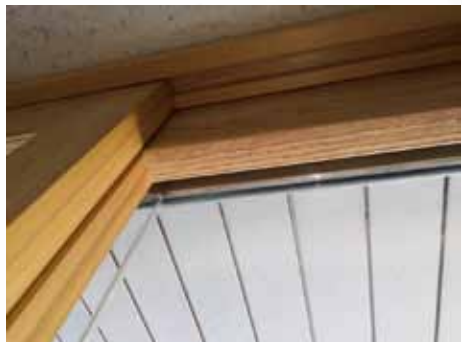
Bingkai tingkap yang dibuat dari OPT plywood dengan Sugi veneer sebagai permukaan terletak di Hotel Gero.
