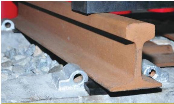
Pad landasan - diletakkan di antara landasan dan ranjang kereta api - bagi mengurangkan hingar dan getaran.
